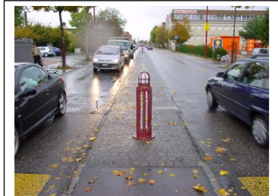
La riqualificazione di Bernstrasse a Zollikofen: la realizzazione di una fascia polivalente centrale e le corsie ciclabili laterali in carreggiata.
