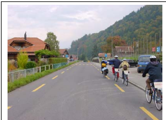
La carreggiata di un attraversamento urbano: 4.70m di corsia a doppio senso di marcia senza mezzzeria e corsie ciclabili laterali.
